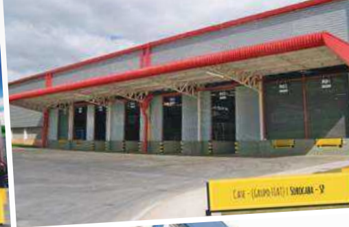
CENTRO DE DISTRIBUIÇÃO | CAMPINAS - SP
